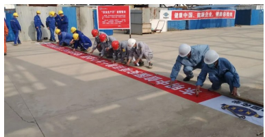
△第二安装公司山东东明项目部
