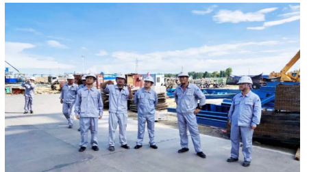
公司副总经理杨凯华检查海南华盛项目建设情况
