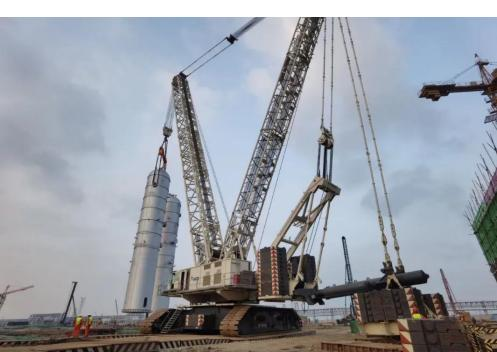
工人的辅助下垂直纵立，做到地面承台地脚螺栓与洗涤塔底部螺栓孔洞无缝对接，充分展示了六化建大型设备吊运安装的非凡实力。
