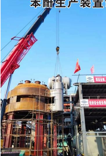
12月18日下午，中国化学工程第六建设有限公司山东分公司承建的国内单套生产能力最大的苯酐生产装置——山东朗晖石油化工股份有限公司8万吨/年苯酐项目氧化反应器一次吊装就位，标志着项目大件吊装完美收官。
