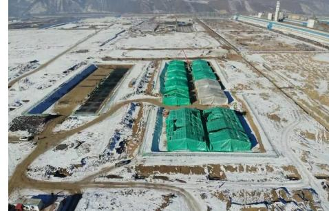
资；浇筑后，在基础铺塑料膜、覆盖土棉被，安排人员24小时看守火炉，保证混凝土暖棚温度达标。
