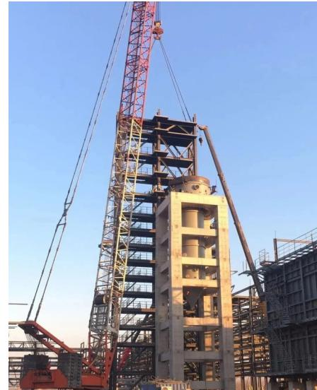
万吨/年重油加氢裂综合项目300万吨/年渣油加氢裂化装置项目第一台超百吨设备减压塔的底部一次吊装成功，为后续大件吊装工作开了个好头。
