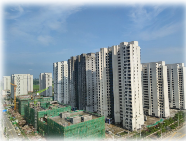
▲襄阳市东津新镇（一期）工程项目
