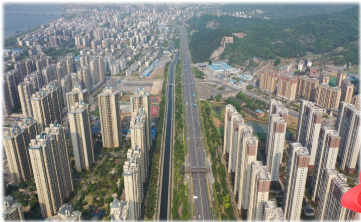
▲襄阳市襄城区集中供暖项目（二期）已完成道路敷设
