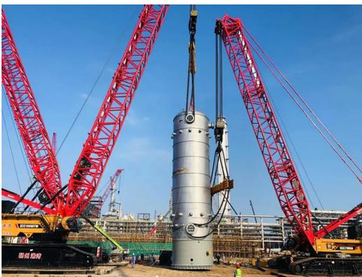
近日，中化六建第五分公司承建的江苏瑞恒新材料科技有限公司碳三产业一期工程40万吨/年环氧丙烷装置项目，顺利完成该项目最重设备721吨P0反应器的吊装任务。
